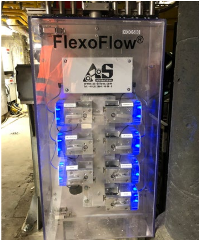
Abb. 3: FlexoFlow® Water zur vollautomatischen Zuteilung von Kühlwasser
