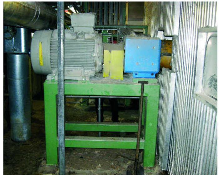
Abb. 1: Standardmotor und Vorgetriebe auf Konsole, außerhalb der Trockenhaube
