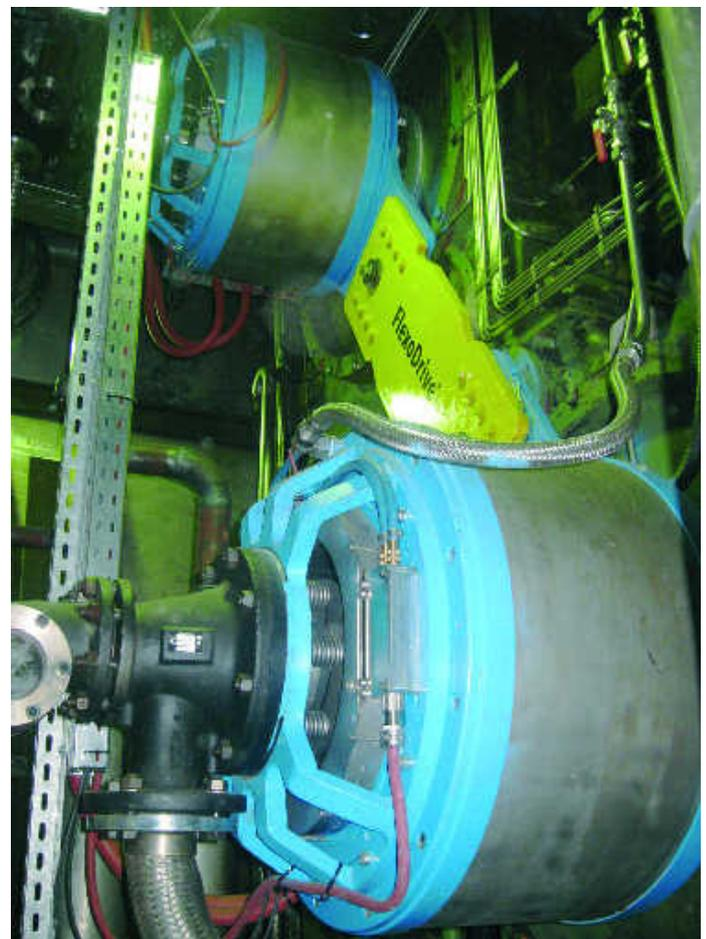
Abb. 8: Kopplung zweier FlexoDrive® mittels patentierter Drehmomentstütze
