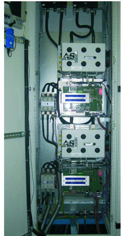
Abb. 6: Einblick in den Schaltschrank mit den Wechselrichtern
