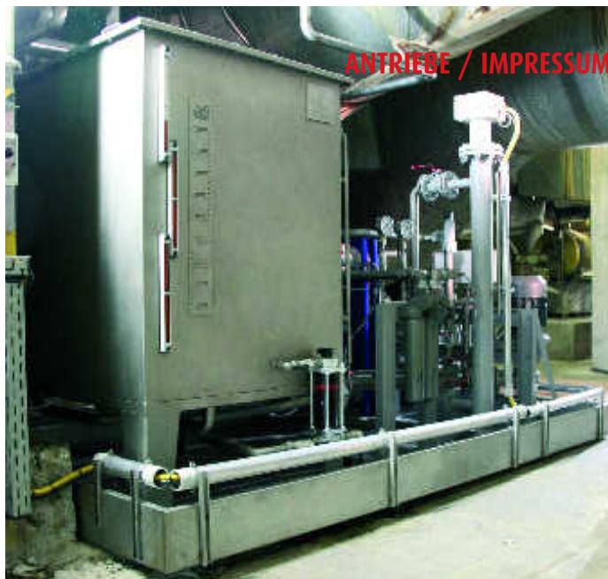
Zentralschmieranlage Lubriflex® zur Versorgung des GearClones
