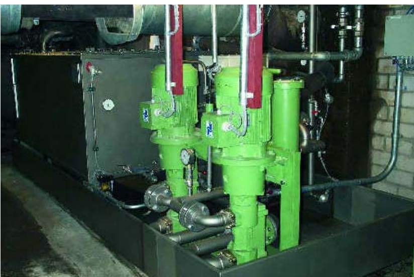
Abb. 1: Öl-Umlaufschmieranlage Lubriflex® Bj. 2004
