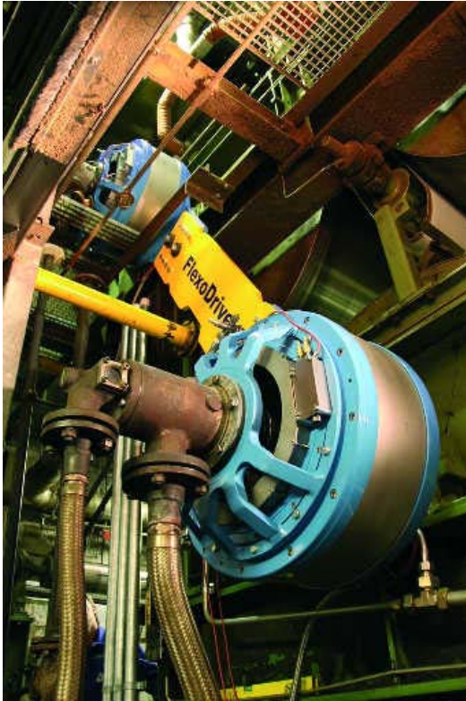
Abb. 4: Hohlwellendirektmotor FlexoDrive® mit je 35 kW
