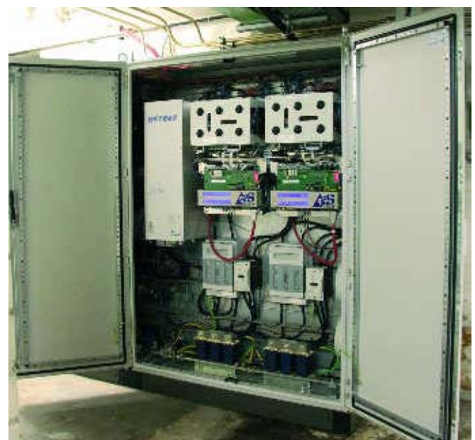
Abb. 8: AS-Frequenzumformer PM/PD Converter 1000 – Erster von AS gebauter Papiermaschinen-Profi-Drive-Converter
