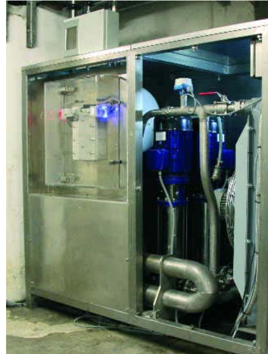
Abb. 6: Kühlwasseraggregat Cooliflex® mit Regelungsorgan FlexiFlow® Water
