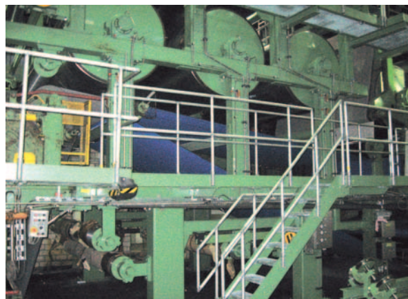
Einbau der ersten Trockenzylinder
