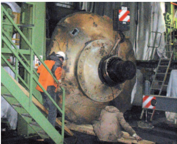
Demontage des Glättzylinders
