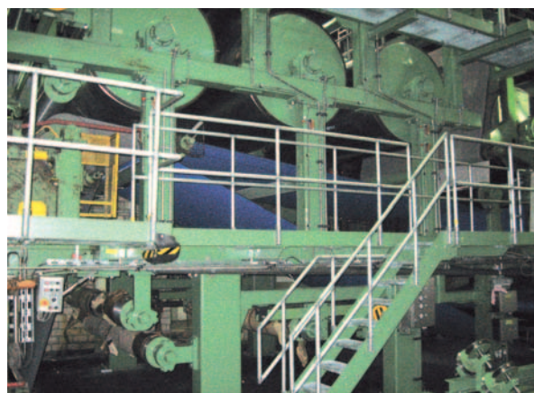
Einbau der ersten Trockenzylinder
