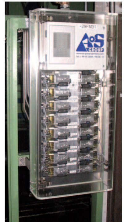
Transfuser System mit Durchflussreglern FlexoFlow
